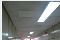
事務所廊下照明のLED化
