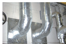
配管保温の強化
